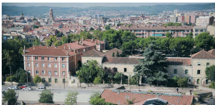
Obres a l'antiga caserna per garantir-ne la seva seguretat | Roger Benet
