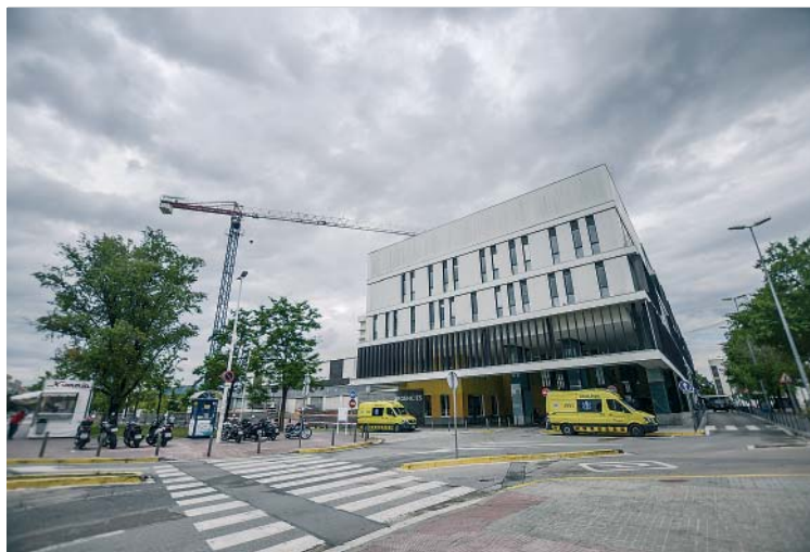
En marxa de nou les obres al Taulí | Roger Benet
